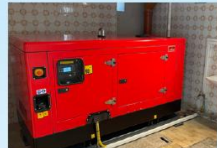
Nachrüstung Stromaggregate f. Blackout-Vorsorge bei der Abwasserentsorgung
