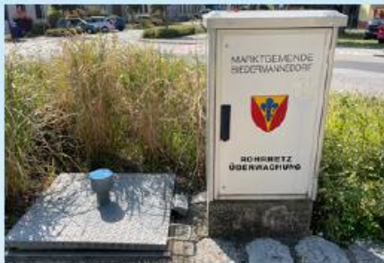
Wasserleitungserneuerung vom Hauptschacht bis komplette Wildenauer-Kreuzung
