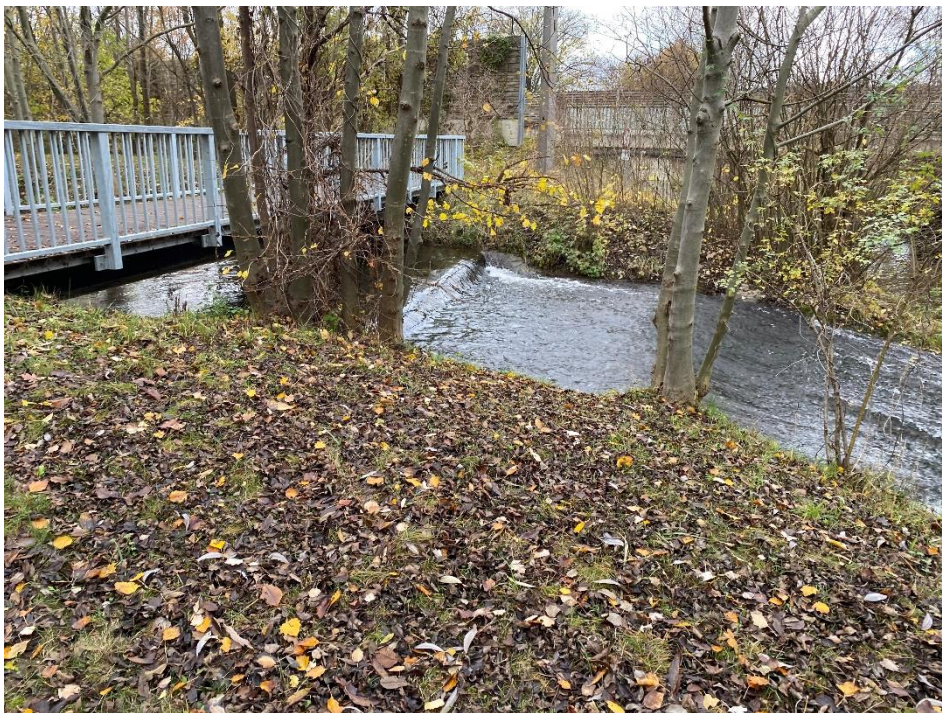
Bild 2: Bestehender Absturz und Steg
